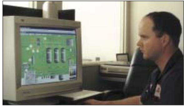
A PC-BASED OPERATOR STATION RUNNING STANDARD WINDOWS NT IS CONNECTED TO THE CONTROL SYSTEM AND PLANT TERMINAL SERVER VIA ETHERNET LOCAL AREA NETWORKS.
