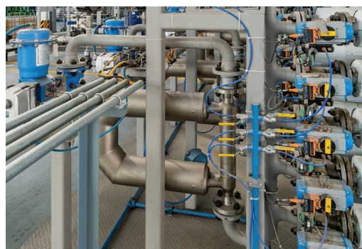
В поточных смесителях Emerson применяются лучшие в своем классе кориолисовые расходомеры Micro Motion®. Фотография предоставлена Copton.
