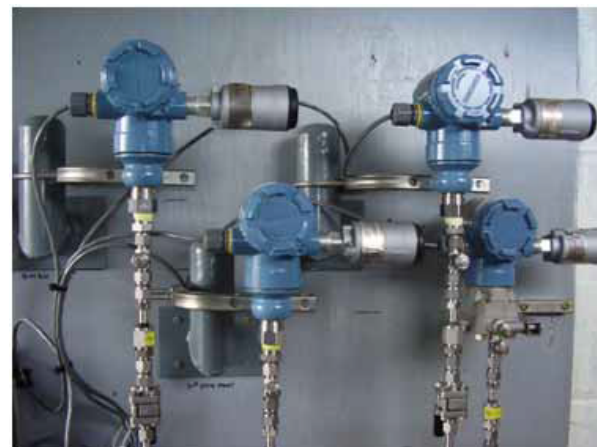
带智能无线THUM适配器的罗斯蒙特压力变送器2051
