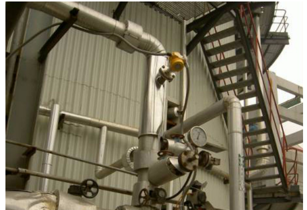
FGD 过程管道中安装高准 7828 型直插式密度仪表
