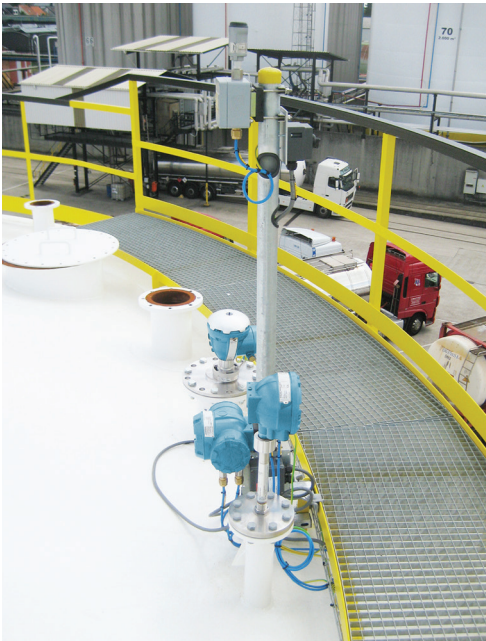
Figura 9.8: Antena conectada a dispositivos del tanque.
