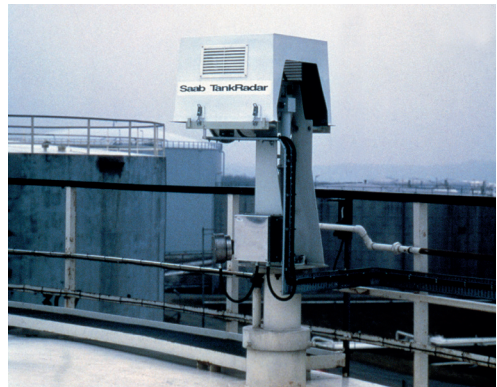
Figura 2.9: Primer medidor por radar de alta precisión instalado en 1985 en un tanque de refinería.
