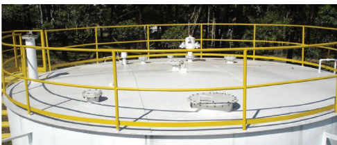
Figura 2.14: Aberturas del tanque de techo fijo.
