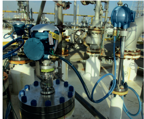
Figura 9.3: La redundancia del tanque se logra con medidores duales de tanques y capas de comunicación separadas, cableadas e inalámbricas.
