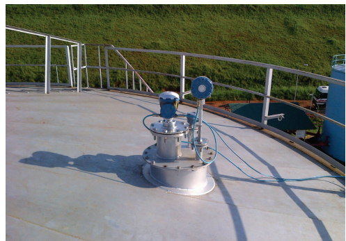
Figura 3.4: Los túneles se encuentran generalmente ubicados cerca de la pared del tanque, lo que proporciona estabilidad mecánica.
