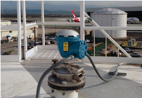
Figura 2.10: Medidor de nivel por radar moderno en un tanque de techo fijo.
