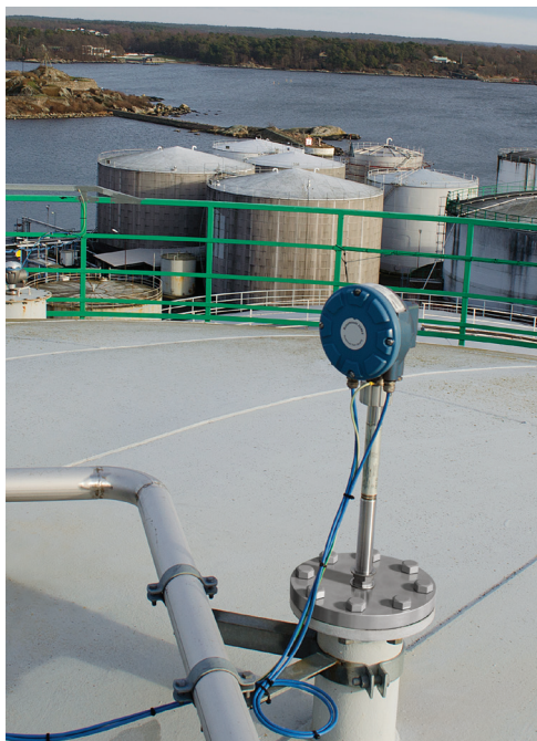
Figura 6.1: Transmisor de temperatura de montaje superior para hasta 16 elementos de temperatura de punto.
