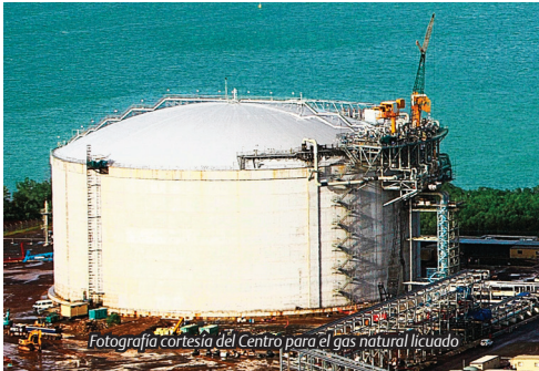
1.4: Tanque criogénico que almacena LNG a -162 °C.
