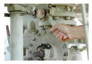
MOVING THE VALVE OPERATING LEVER HALFWAY OPEN GIVES FASTER EQUALIZING
