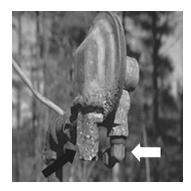
CORROSION DUE TO BELOW GROUND LEVEL INSTALLATION
