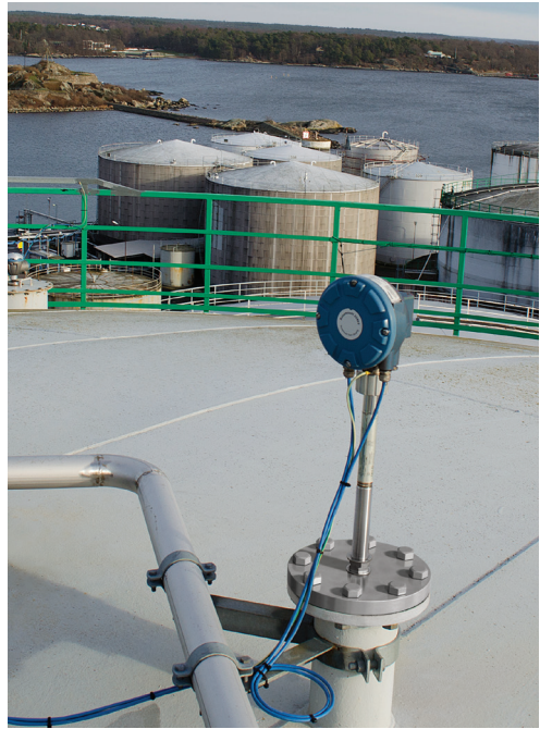
Figura 6.1: Trasmettitore di temperatura montato sul tetto per un massimo di 16 elementi di temperatura spot.
