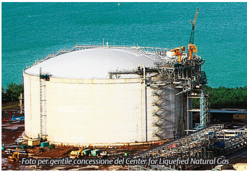
1.4: Serbatoio criogenico che immagazzina GNL a -162 °C.
