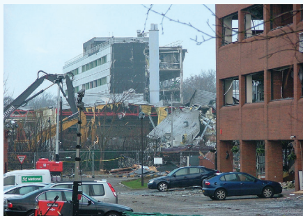
Figura 10.1: Danni alla proprietà dopo l'incidente a Buncefield.
