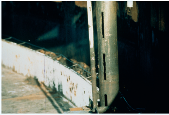
Figura 2.16: La misura radar a bassa perdita può essere utilizzata per eliminare praticamente il degrado della misura nei vecchi tubi di calma.
