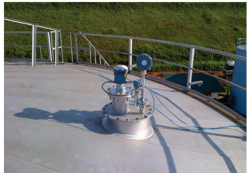
Figura 3.4: I passaggi d'ispezione sono normalmente situati vicino al muro del serbatoio che fornisce stabilità meccanica.
